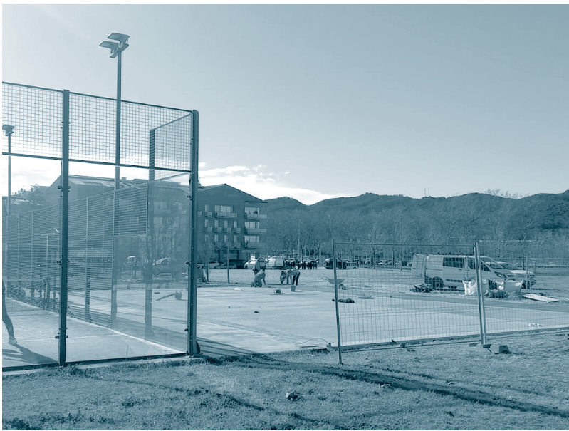
Imatge de les obres de segona pista de pàdel, al carrer Pins d'en Ros.
